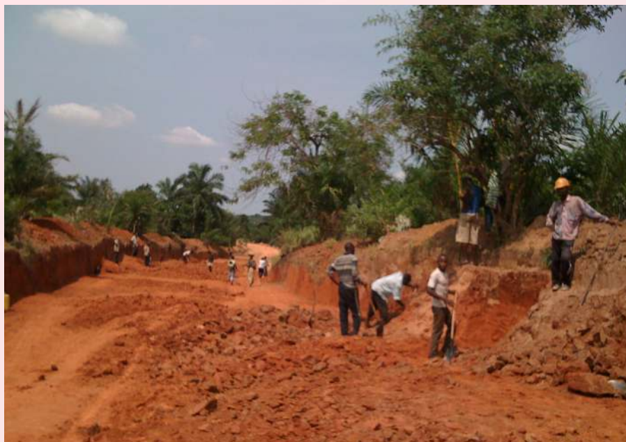
158 km de pistes rurales ont été réhabilités sur les 208 prévus par le projet.
